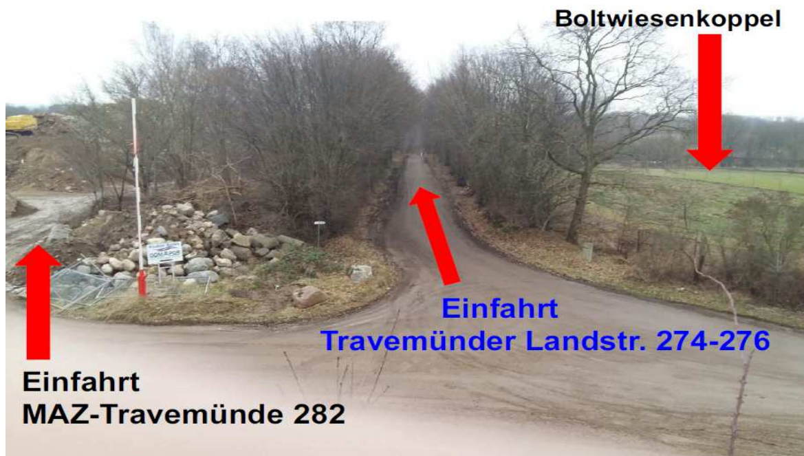
Abb. 15: Einfahrten an der Travemünder Landstraße zum MAZ-Gelände und zum IO-2 Bild: Privat
