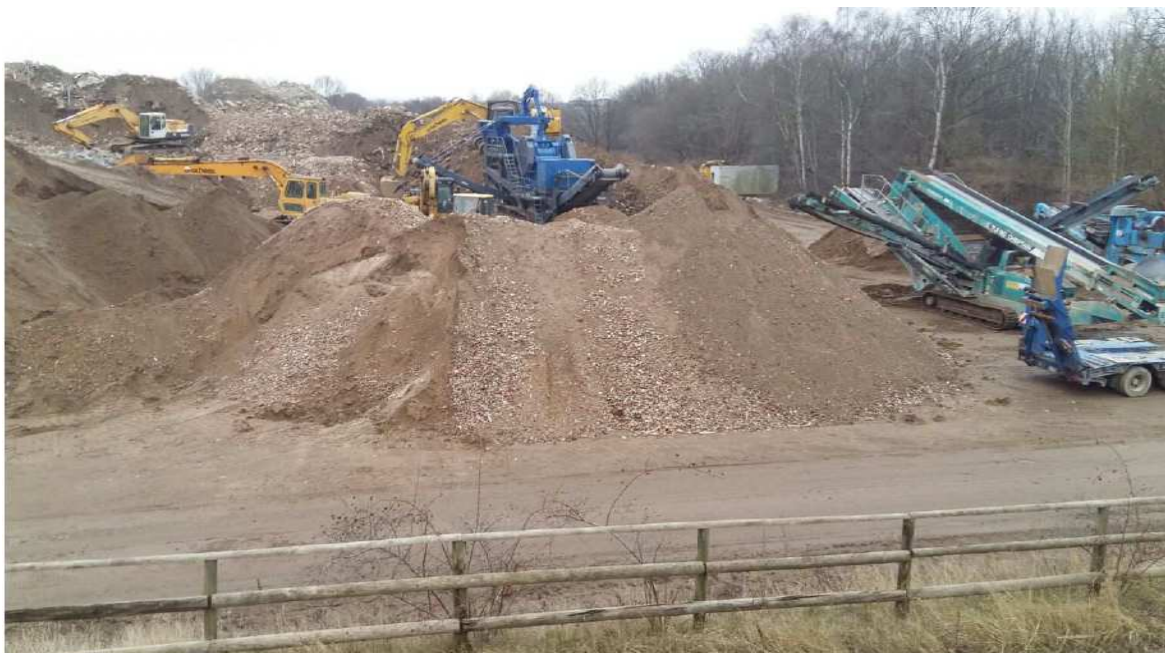
Abb. 16 mobiler Maschinen-Einsatz im nördlichen Eingangsbereich des MAZ © Privat 21.1.2017
