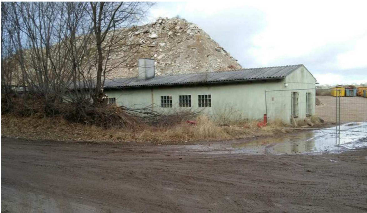
Abb.8 Überhöhte Abfallhalde südliches MAZ-Gelände + angrenzender Containerbereich Foto: PP-2017
